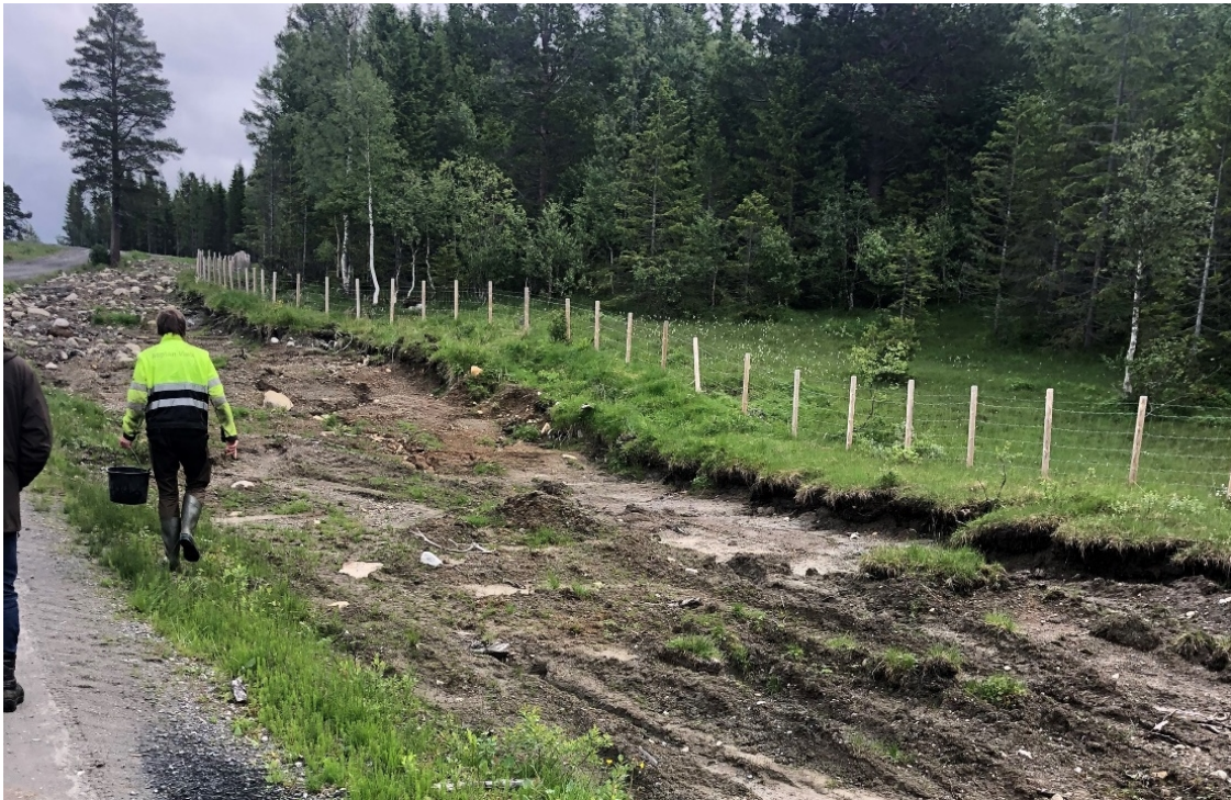
6-8. Ny parkeringsplass som er planlagt langs grusveien, rett nord for oppkommet og brønnområdet.
