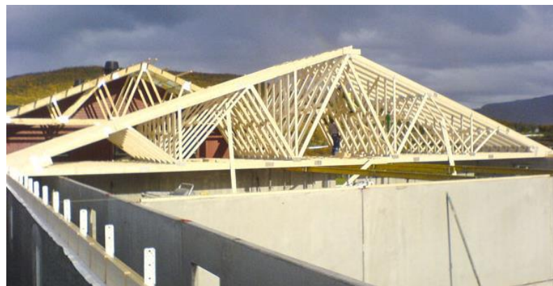
Støren Treindustri produserer takstoler av lokalt trevirke. Kapp og ubrukt trevirke blir råstoff til fjernvarme. Foto: Støren Treindustri.
