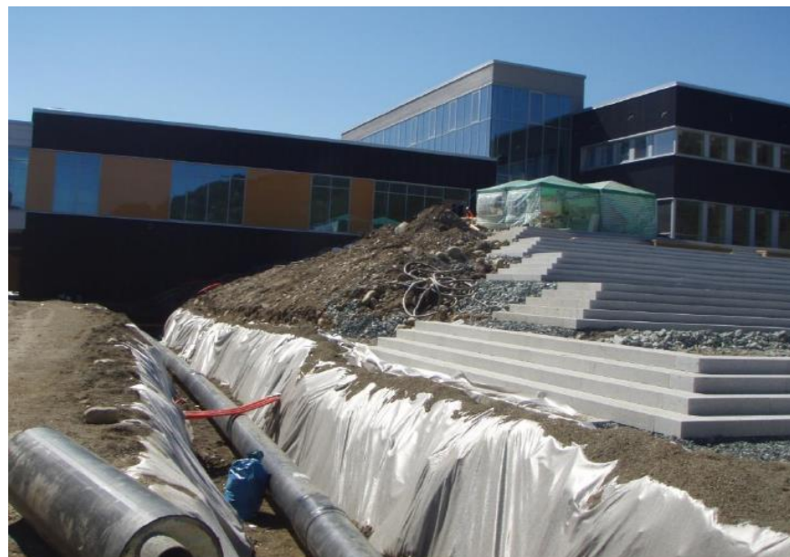
Etablering av vannbåren varme ved Gauldal videregående skole. Foto: Midt Energi AS
