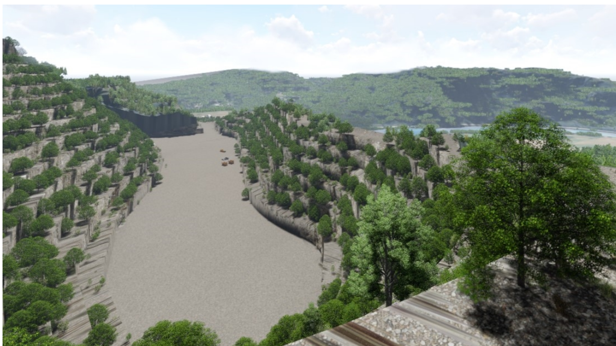
Figur 6-7-2: Modellbilde som illustrerer steinbruddet etter maksimalt uttak. Bildet viser at terreng bevares ut mot Gauldalen og vil skjerme for innsyn til bruddet.
