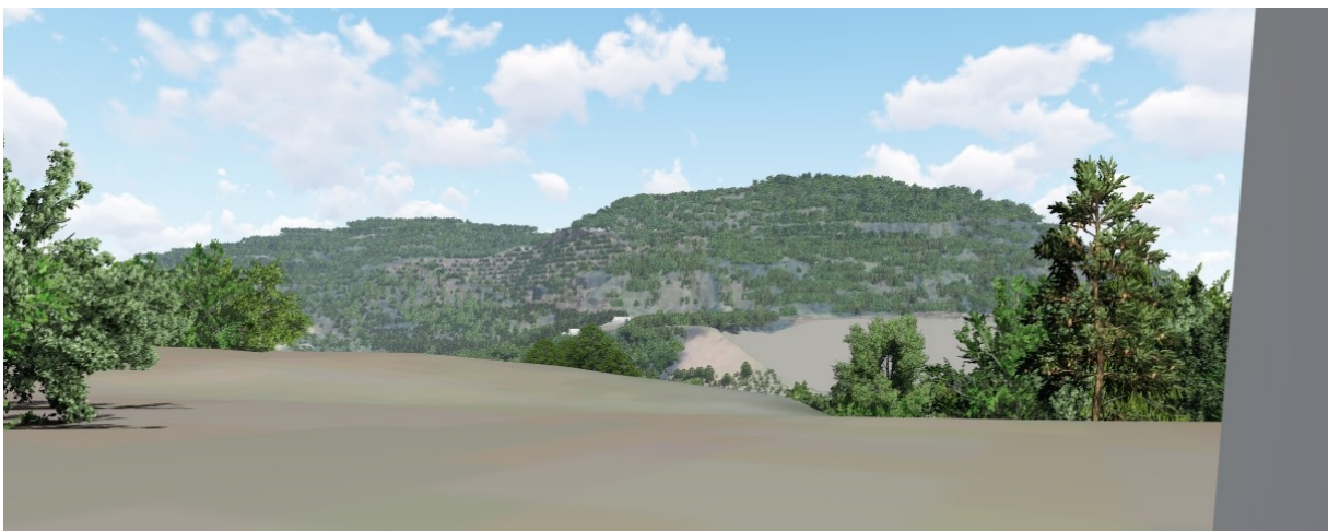
Figur 6-7-6: Modellbilde med ståsted på Granmoen som illustrer hvordan steinbruddet og masseuttaket vil kunne se ut etter maksimalt uttak. Vestveggen i steinbruddet er omtrent midt på bildet. Masseuttaket er til høyre på bildet. Vegetasjon i ytterkant av terrassen vil skjerme for innsyn.
