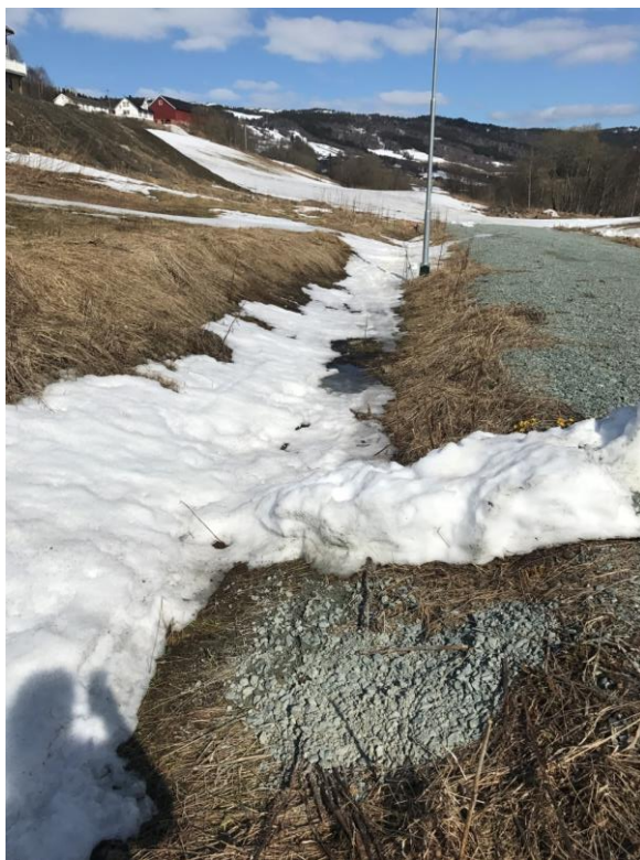
Figur 8: Vann i veggroft på platået som skal bebygges.
