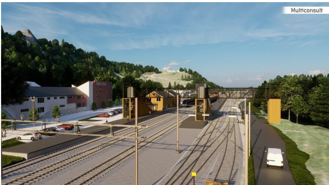
Figur 16 Planlagt utbygging med ny overgangsbru, plattformer og nytt spor sett fra sør.
