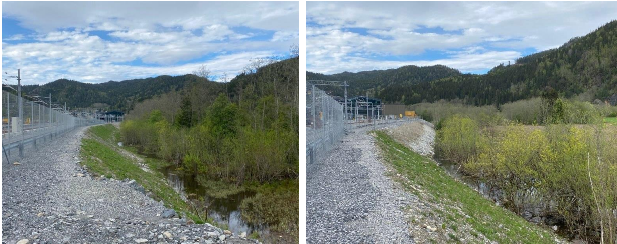
Figur 17 Adkomstveg til nytt verksted er bygd med bred skulder på utsiden av sikringsgjerdet for å ivareta turvegtrase. Flomskog vises til høyre for vegfyllingen.
