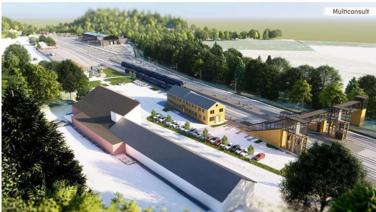
Figur 14 Planlagt utbygging med ny overgangsbru, plattformer og nytt spor sett fra sørvest.
