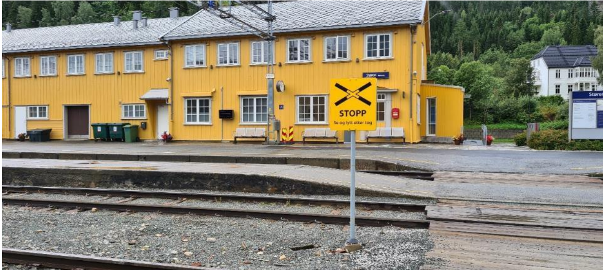
Figur 12 Støren stasjonsbygning. Foto: Multiconsult.
