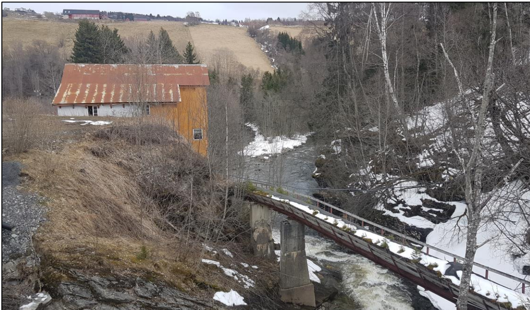
Figur 10 Møllebygningen, Byna med fossen og vannrenna/rørgata ved Fossum.
