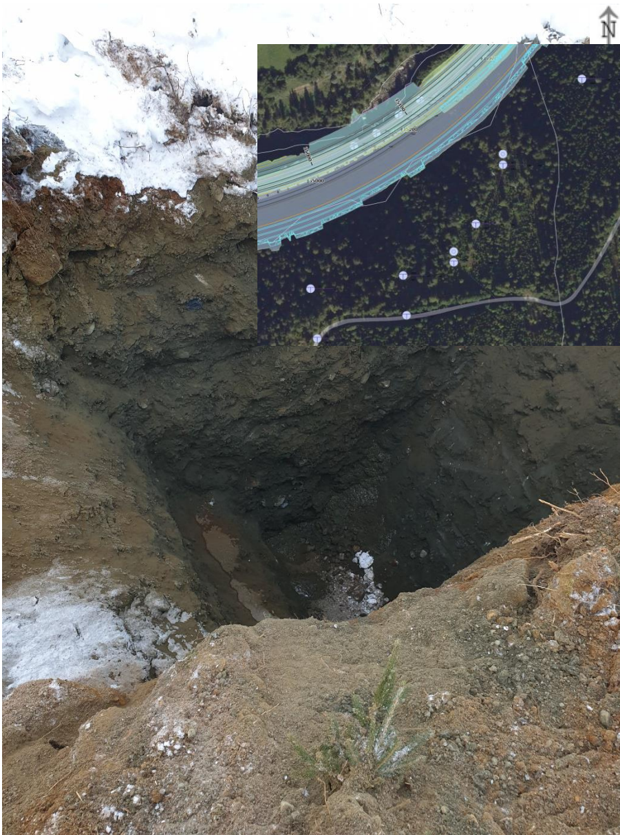
Figur 11 Prøvegravingshull med plassering. Bildet er fra prøvehull lengst i nord.
