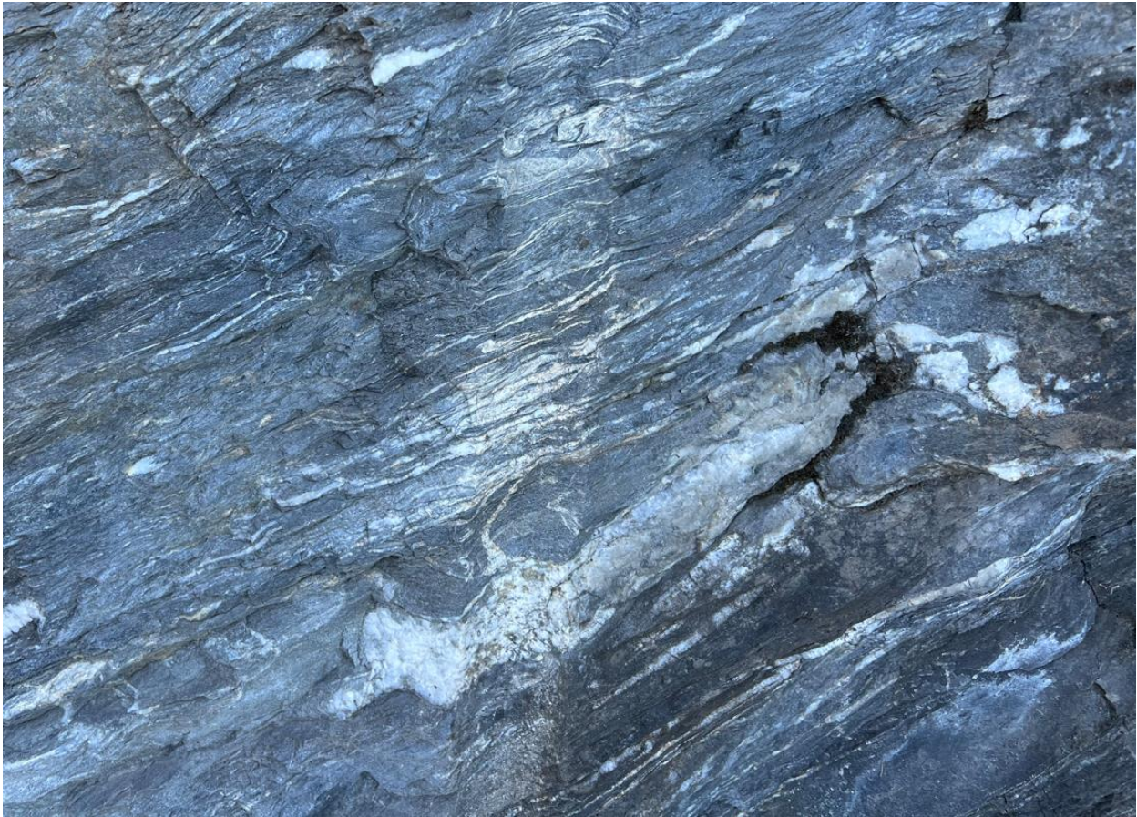
Figur 5 Mer kompetent, småfoldet bergmasse med synlige borpiper mer sentralt i Vindåsliene.
