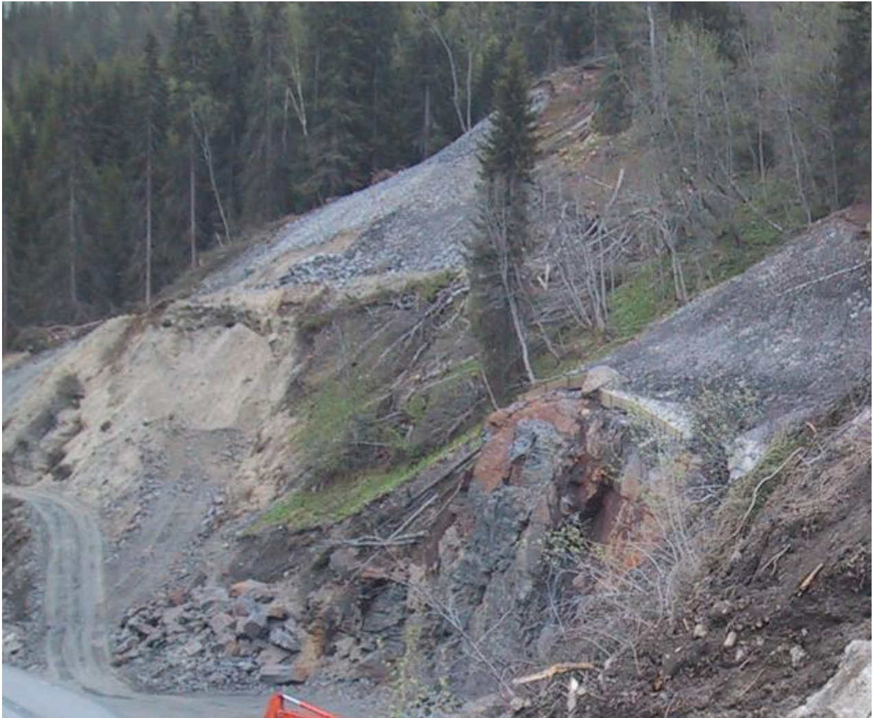
Figur 10 Løsmasser helt nord i Vindåsliene
