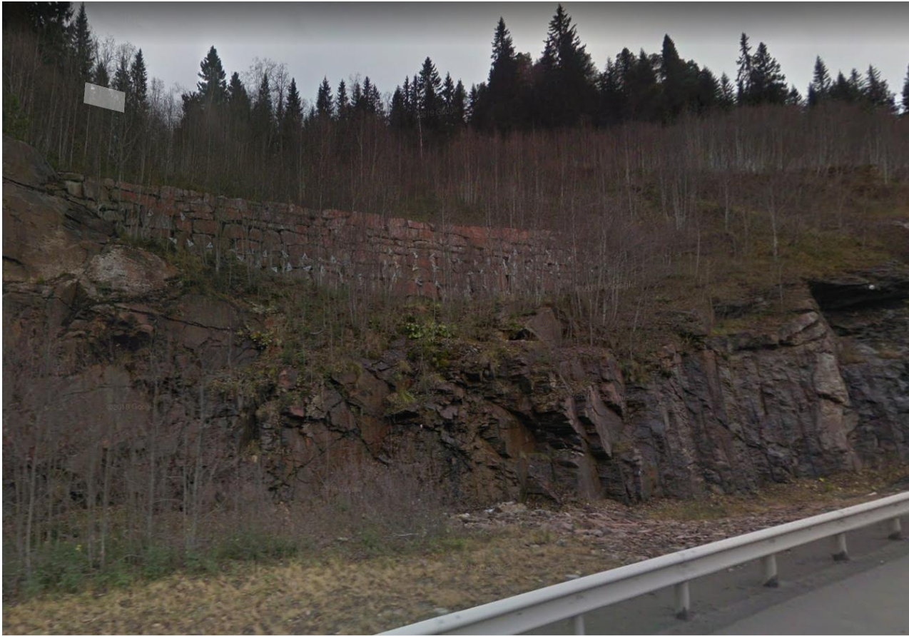
Figur 36 Støttemur i Vindåsliene (Profil ca. 34960–34990) (Foto: Google maps).
