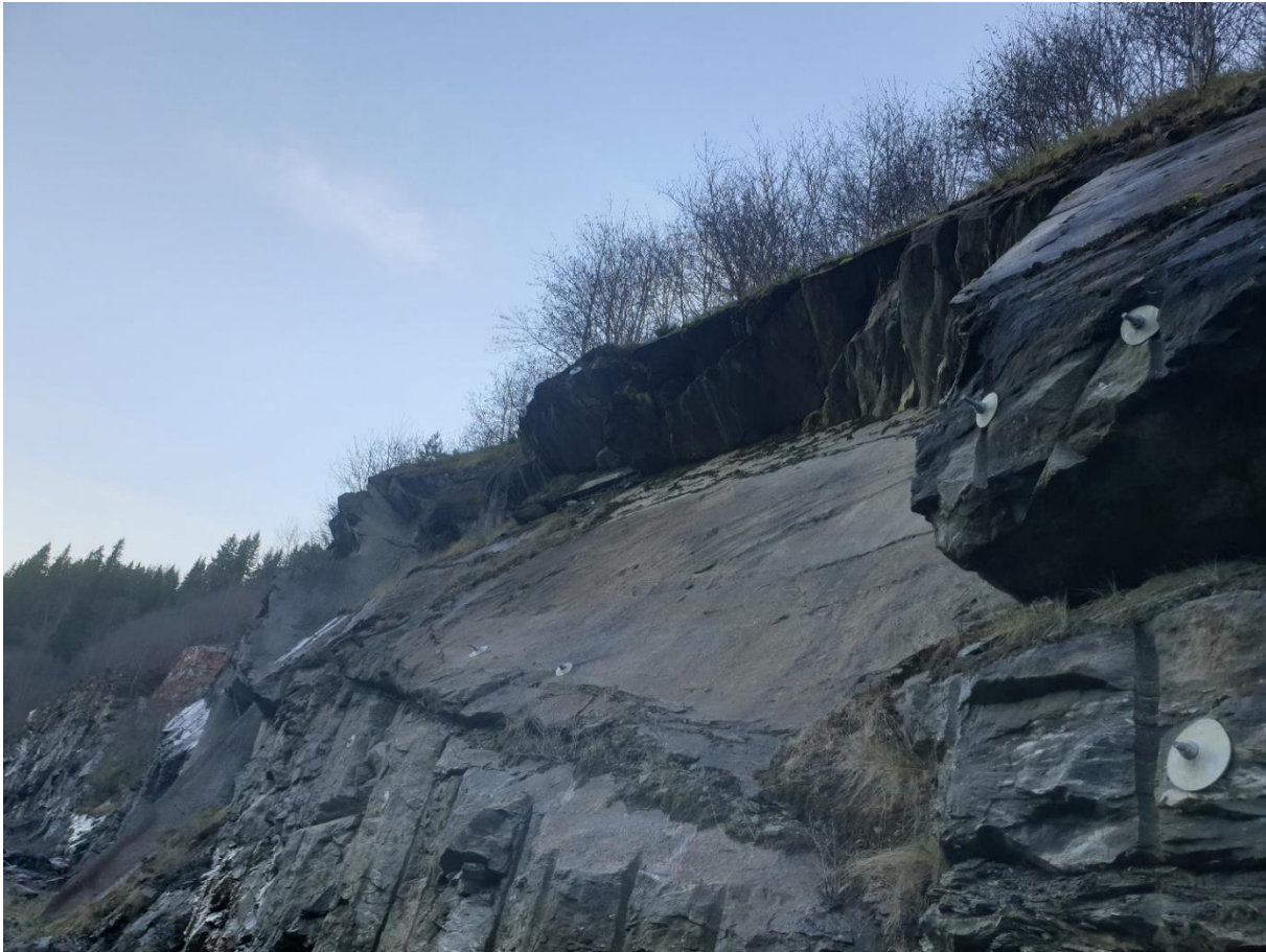
Figur 29 Sprekkeplan 4 med glatte bølgede plan. Bildet er tatt ved profil 34810.
