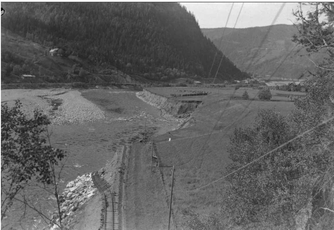
Figur 5-6: Elvebrudd og brudd på jernbanen ved Rognes tunnel, ca. 8,5 km oppstrøms Støren langs Gaula. Kilde: (Digitaltmuseum, 2022).
