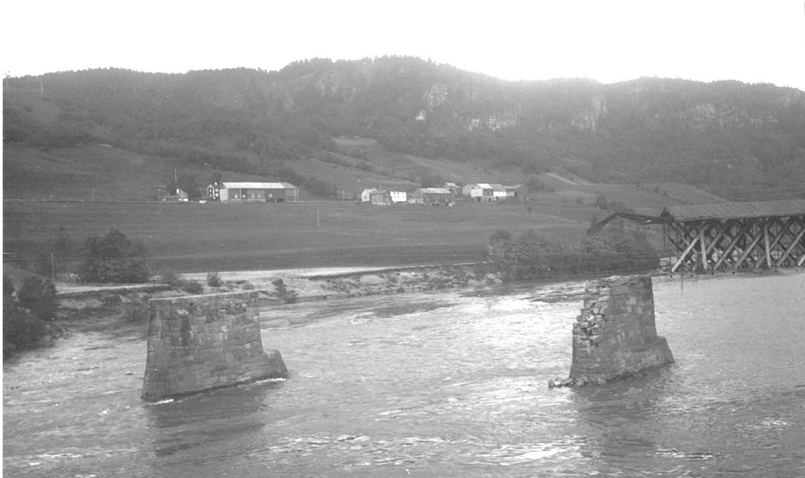
Figur 5-3: Skadet jernbanebru ved Gulfossen, 1918-flommen. Foto: Ukjent.
