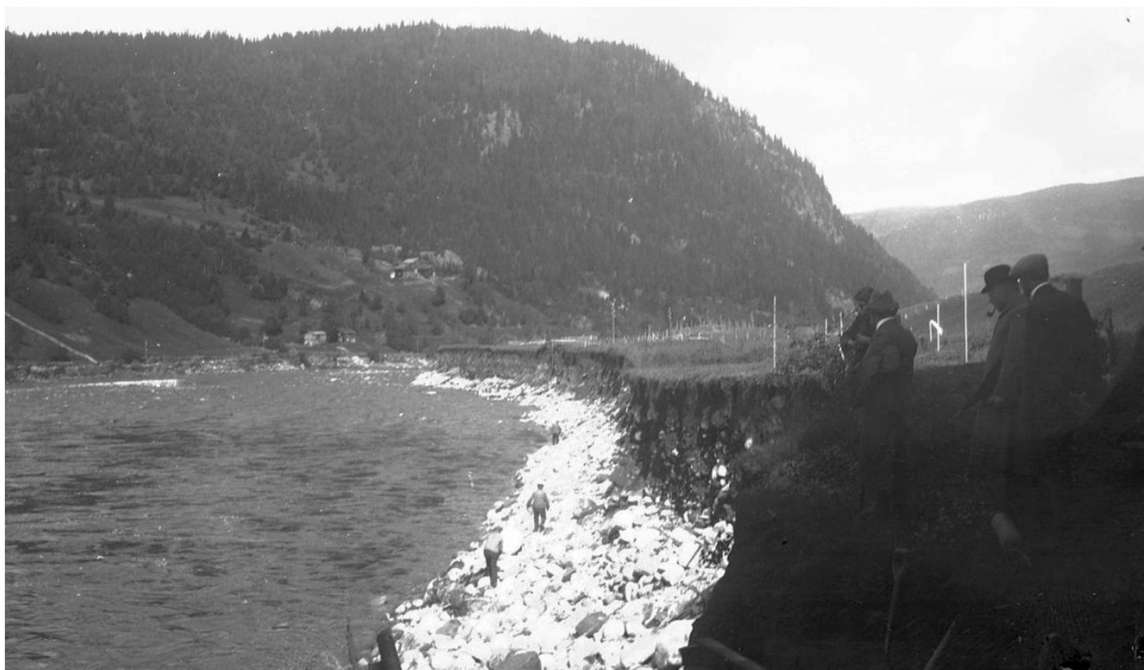
Figur 5-1: Brudd på høyre bredd like nedenfor Rognes tunnel i Gauldalen, 1918-floppen. Foto: Ukjent.
