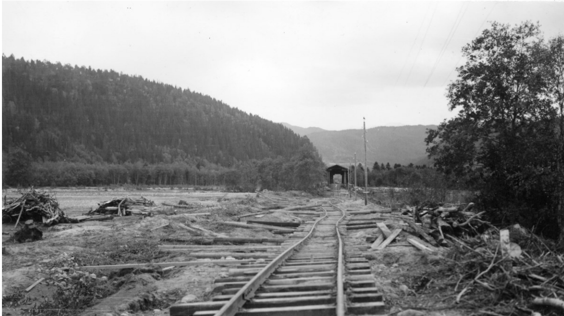
Figur 6-8: Jernbanebruen sett mot Støren stasjon etter 1940-flommen. Kilde: (Strand, 1941)
