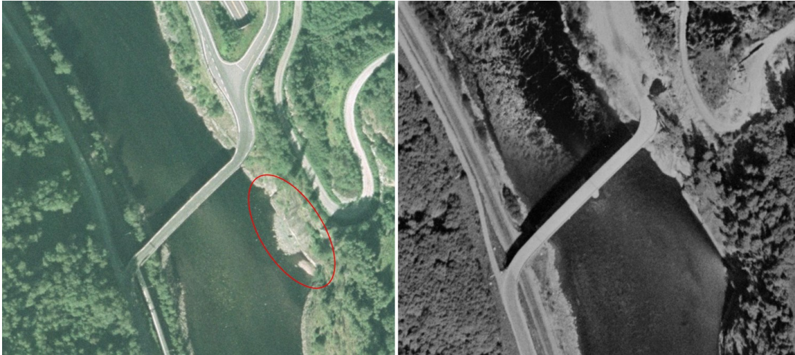
Figur 4-2: Flybilder fra Håggabrua fra 2002 til venstre og 1963 til høyre. En ser at det er noe stein i elva oppstrøms brua (markert med rød sirkel) i 2002.
