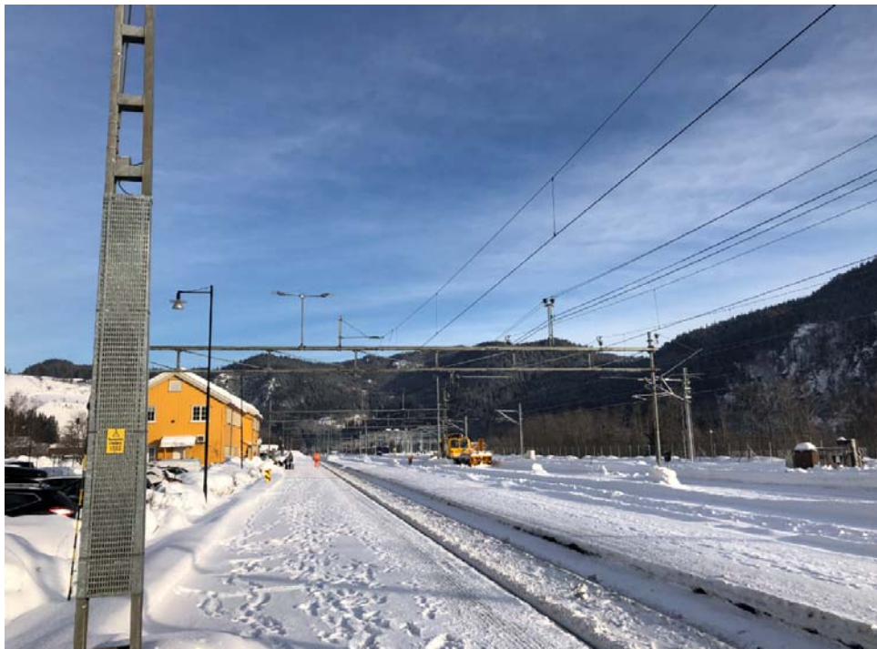
Figur 10 Stasjonsområdet med dagens sideplattform sett fra sør mot nord. Foto: Multiconsult, 22.02.2022.
