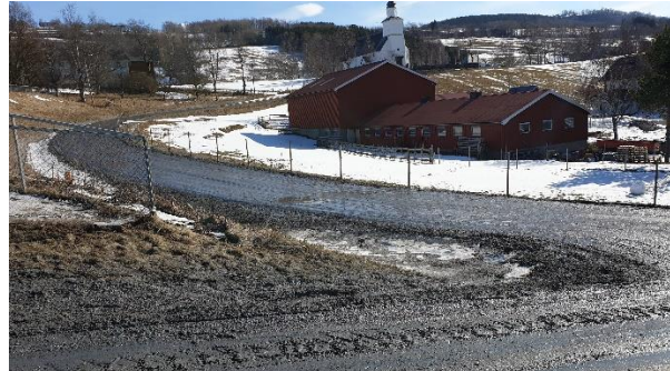
Figur 3 - Dagens adkomstveg til Soknedal kirke
