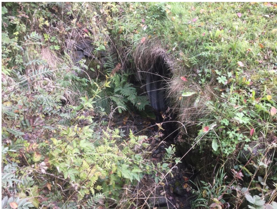
Figur 9. Stikkrenne under jernbanefylling nord for planområdet
