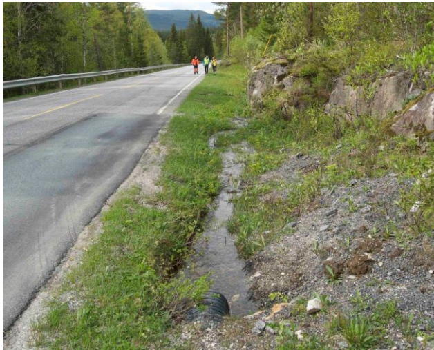
Figur 6.13.4: Viser dagens grøft nord for Fv30 sett fra avkjørsel til Branden Steinbrudd. Sett mot vest.
