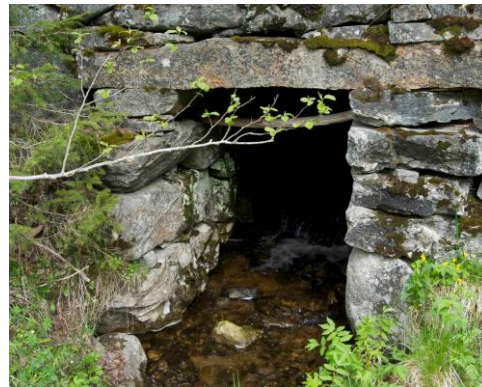
Figur 6.13.8: Viser kulvert for bekk gjennom jernbanelinjen sett fra Sør. Videre går bekken åpent mot Gaula.
