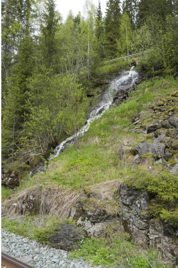
Figur 6.13.6: Viser bekk i skråning mellom jernbanen og Fv30.
