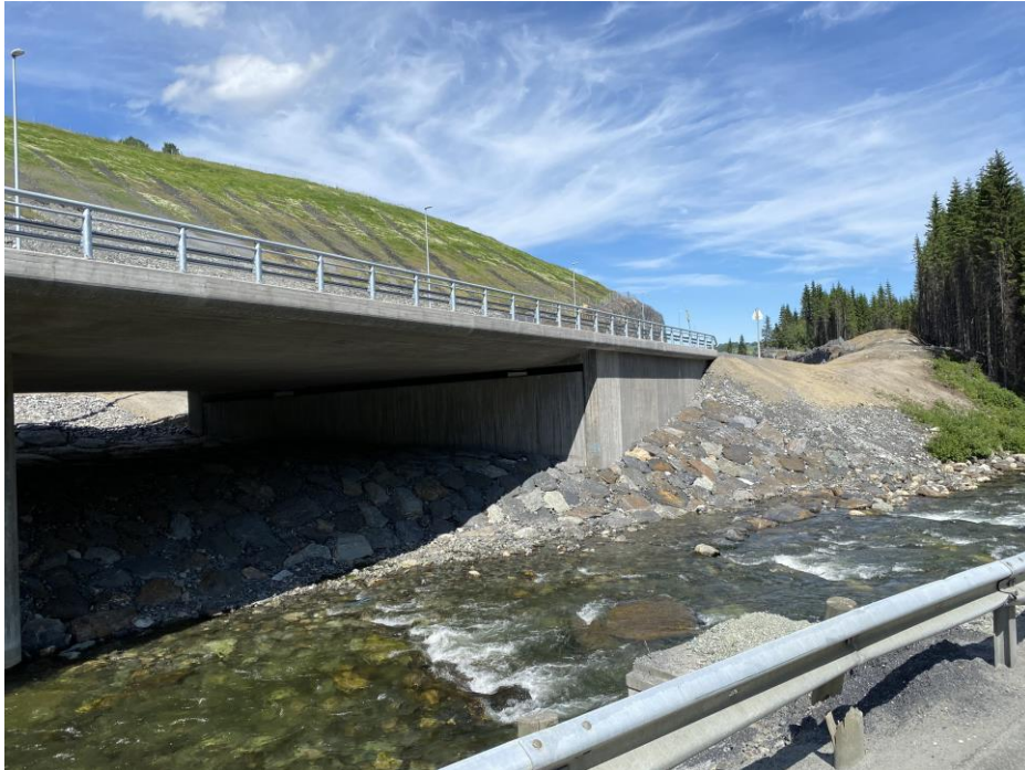
Figur 5 Eksisterende bru sett fra sørøst. Utvidelse er planlagt på denne side av bru
