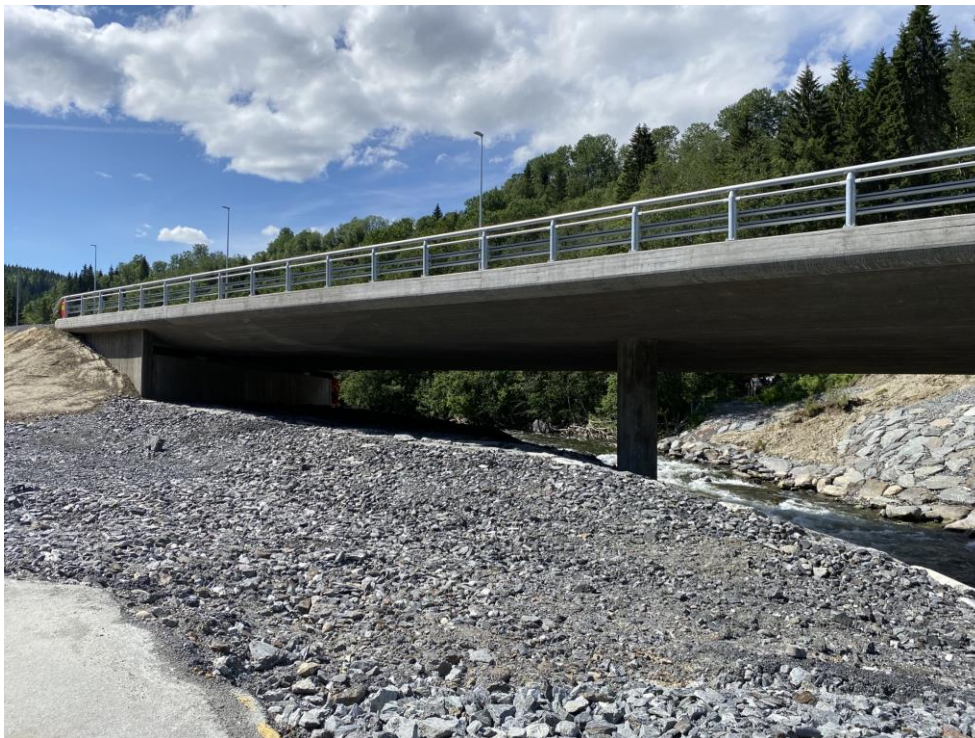
Figur 6 Eksisterende bru sett fra Nordøst. Utvidelse er planlagt på denne side av bru
