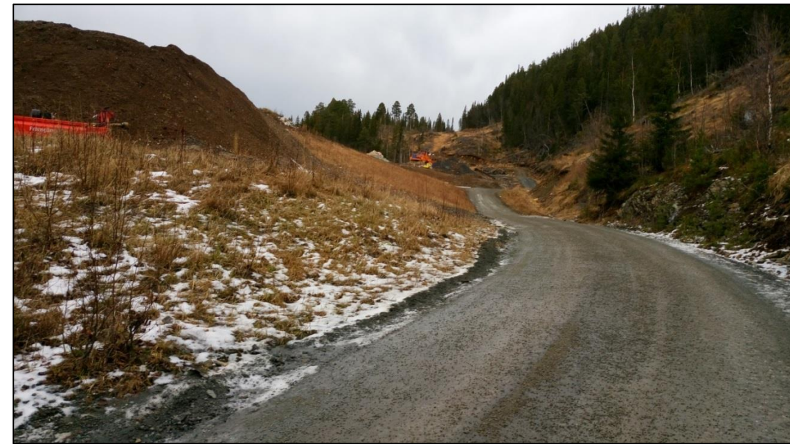
Figur 6: Øvre del av dagens deponi. (foto: Ingrid Engan Nøren).
