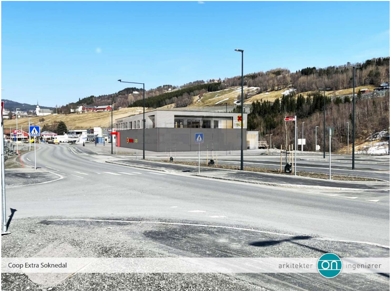
Figur 13: Planområdet sett sørfra. Etablert kollektivknutepunkt sees til høyre i bildets framkant. Det planlagte bygget er plassert relativt langt sør i planområdet. Avkjørsel til planområdet, samt parkeringsplass ligger nord for bygget. Langs byggets vestvegg forutsettes det etablert et kjørbart areal fram til sørsida av bygget, hvor det legges opp til parkering for ansatte, samt punkt for henting av avfall. (ON arkitekter 2021)
