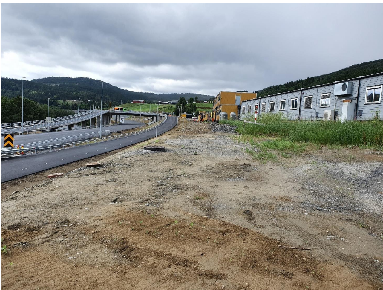
Figur 6: Bilde mot sør som viser området regulert som « annet vegareal » langs østsiden av tomten.
