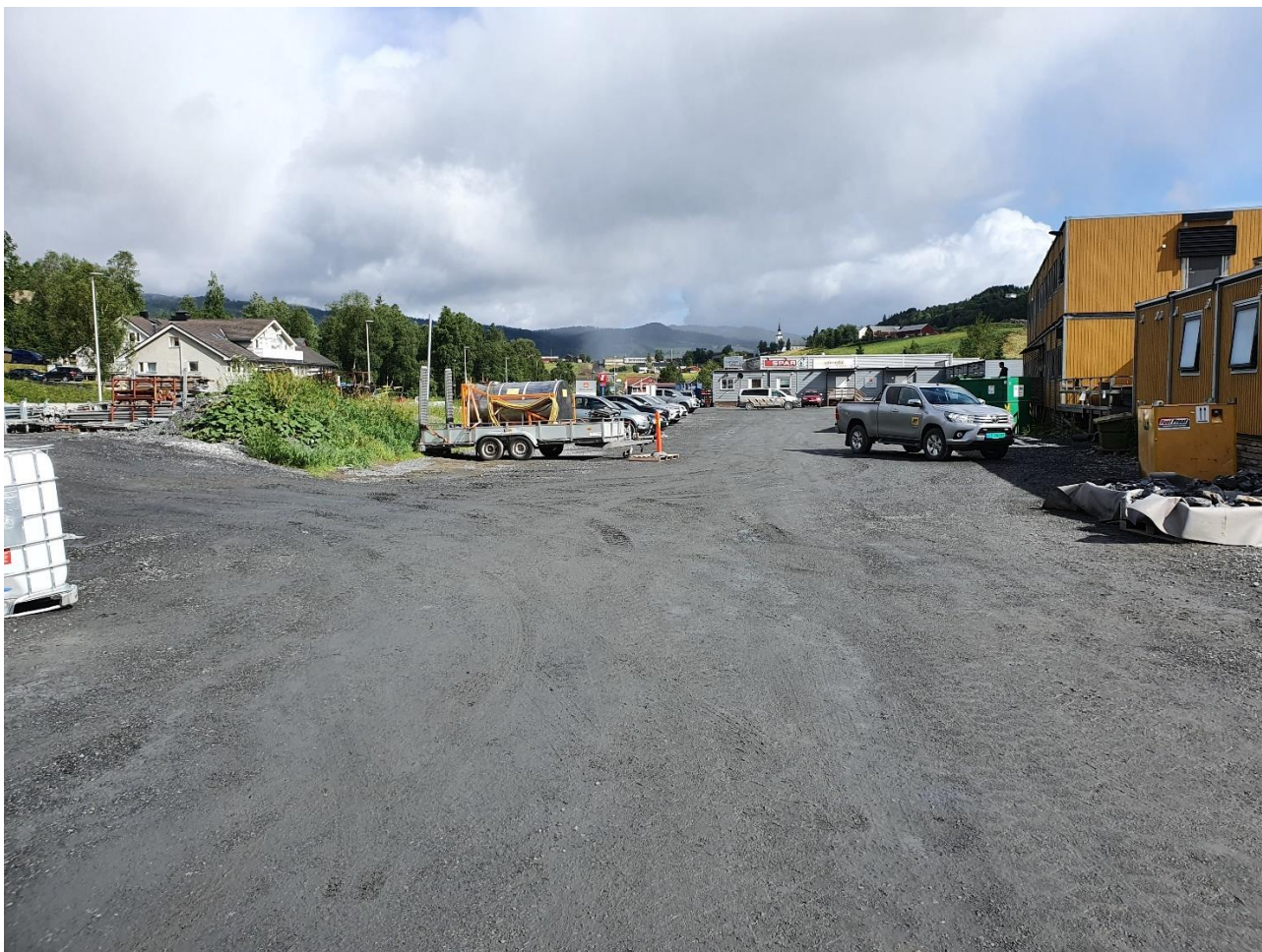
Figur 5: Bildet, tatt mot nord, viser planområdet og hvordan det har blitt gruset opp for å etablere riggplass for anleggsbrakkene.
