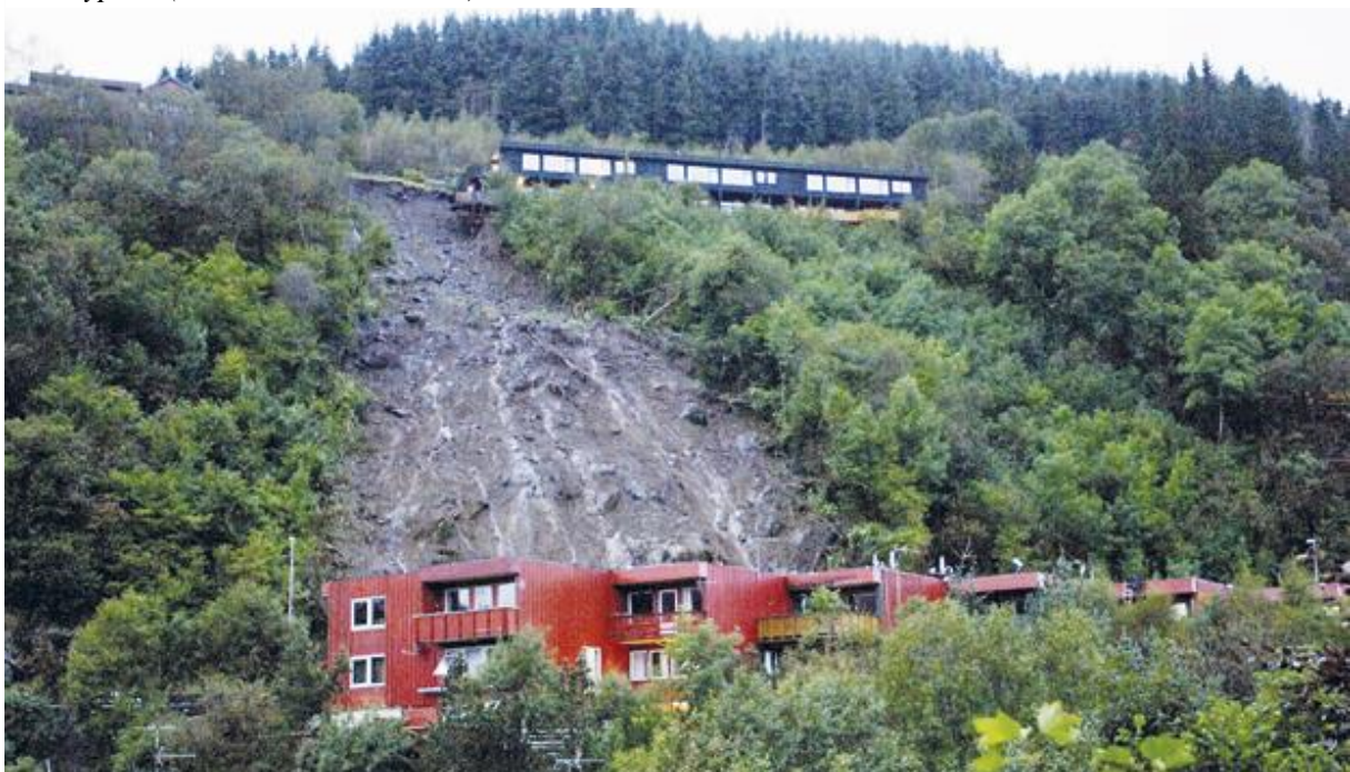
Figur 1.2: Jordskred ved Hatlestad terrasse i Bergen kommune, september 2005 (OED, 2012).
