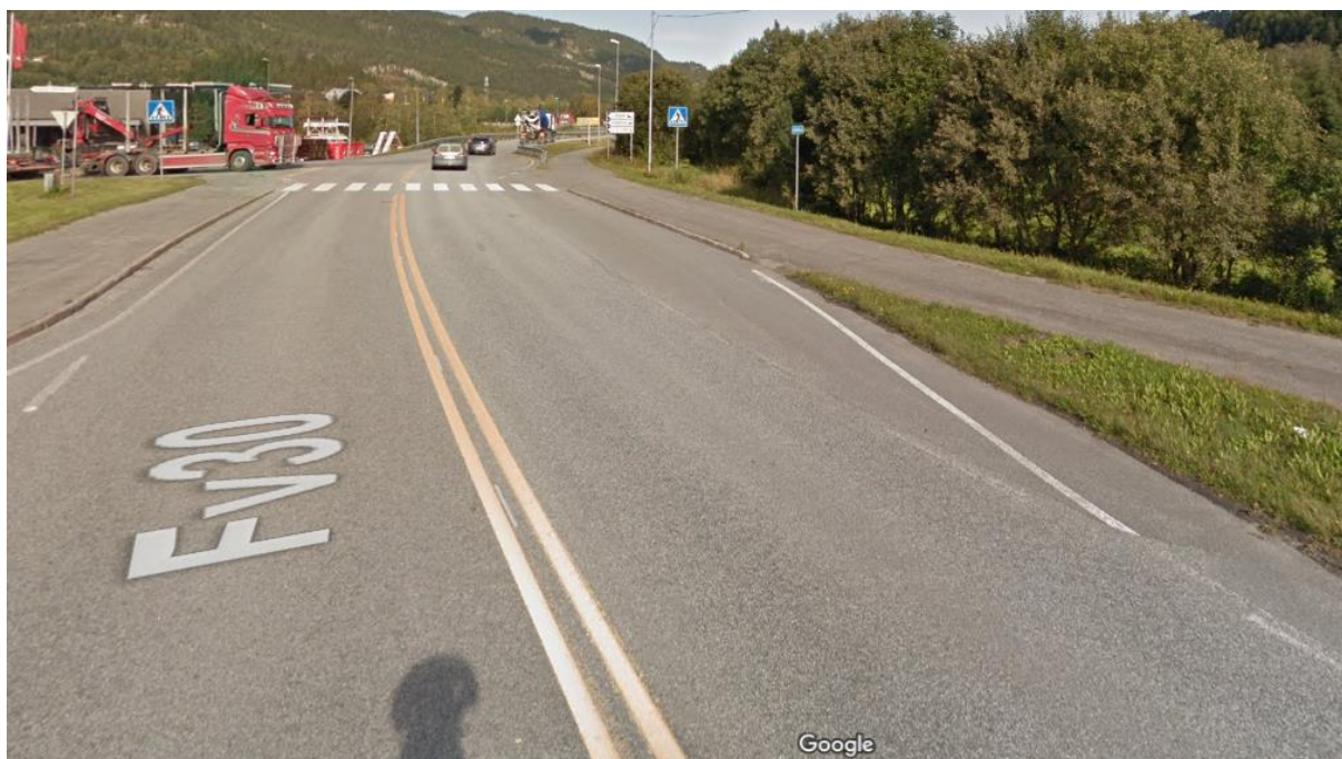
Figur 14: FV30 ved avkjørsel til Kjørkvollveien
