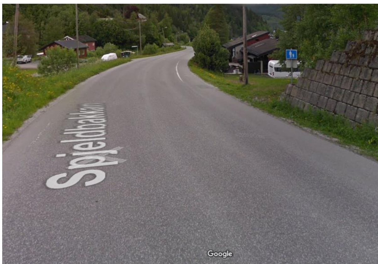
Figur 13 Spjeldbakken – manglende skille mellom fortau og kjørefelt
