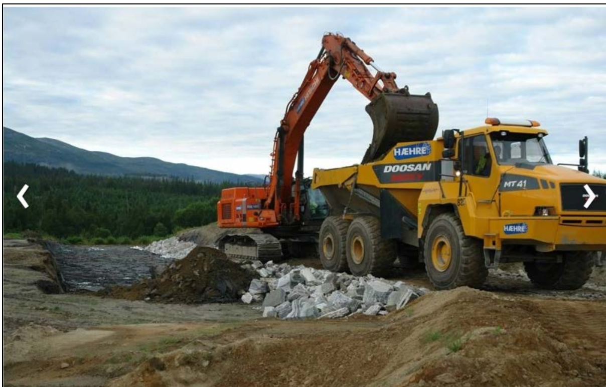
Figur 6-7: Bilde viser leddumper med ca. 40 tonns nettolast (kilde: Bygge.no, 05.11.2016).
