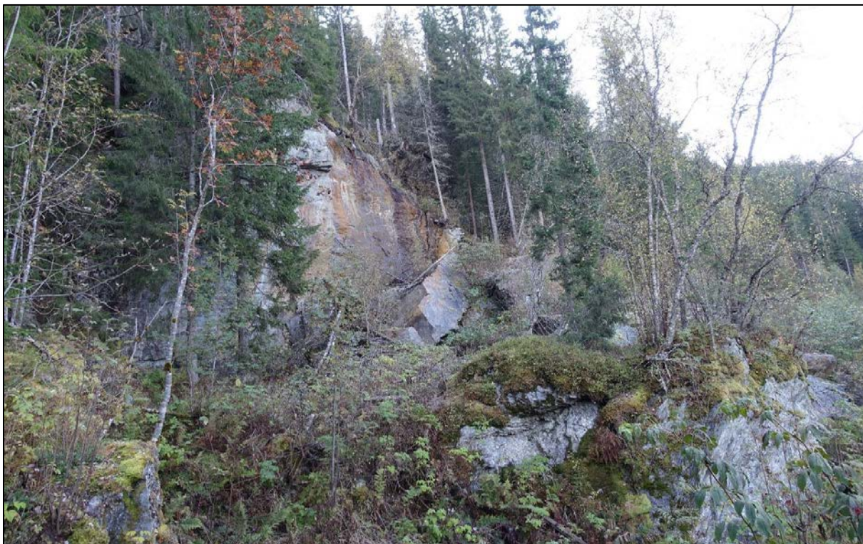
Figur 6-6: Stor fjellskjæring omkring pr 1100 (fotografert Sweco, 10. oktober 2016).
