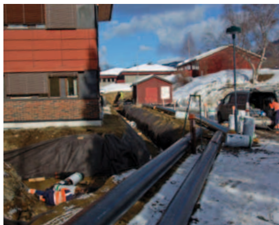
Biovarme til Rådhuset. Det er kanskje ikke rette årstida for graving, men rørgatene er åpnet. Innvendig er det gjort klart for påkobling.
