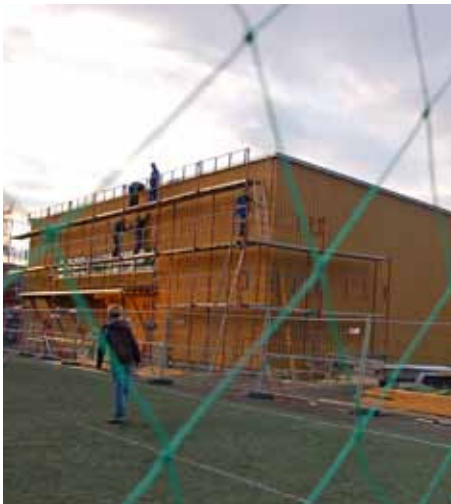
Den nye gymsalen ble åpnet i uke 49. Bygget ble reist på imponerende fire måneder.
