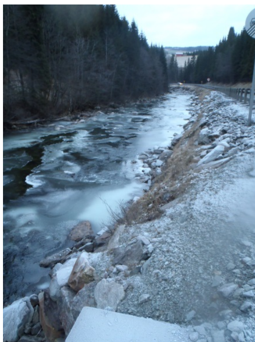
Feltarbeid 20-11-2014. Noe is. Nedstrøms bru
