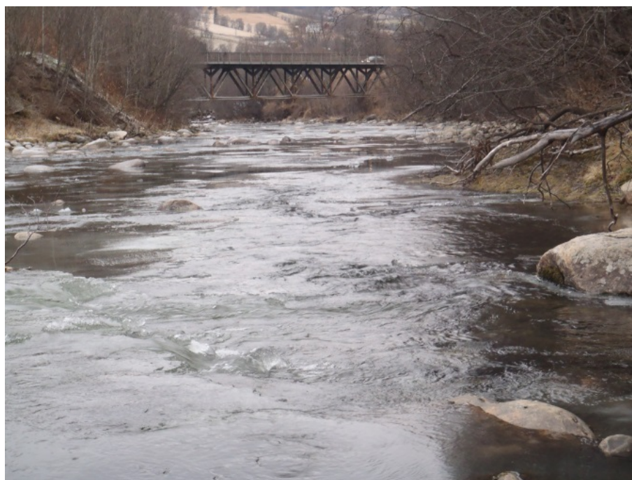
Feltarbeid 20-11-2014. Noe is. Nedstrøms ny bru
