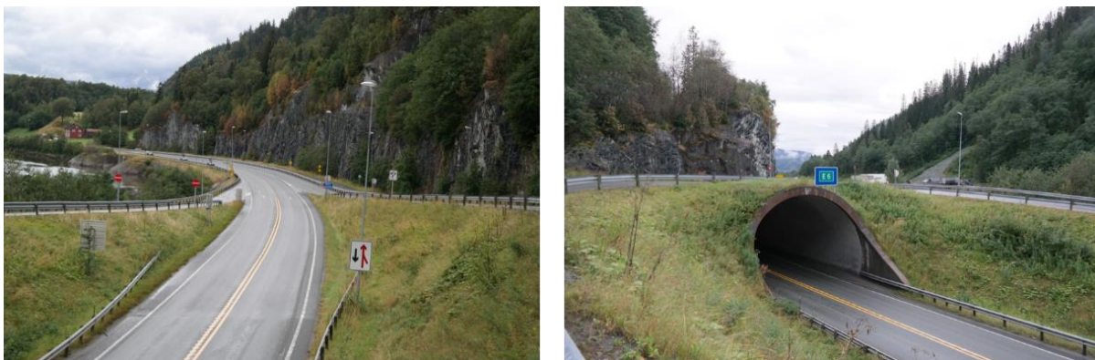
Figur 3-3 Dagens kryss ved Håggåbrua og tunnelportal for Håggåtunnelen. Kilde: Norconsult.
