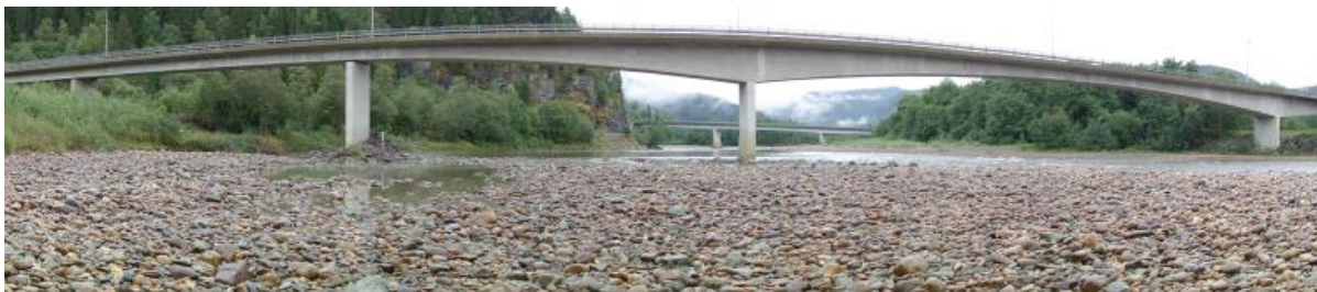
Figur 4-4 Eksisterende bru over Gaula. I bakgrunnen sees fv. 632 Folstad bru. Kilde: Norconsult.
