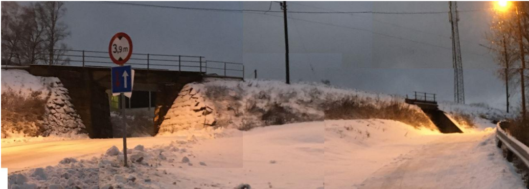
Figur 5-1 Bilde av Rørosvegen og undergang under jernbanen. Kilde: Norconsult.
