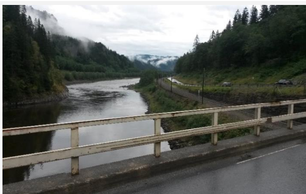
Figur 4-5 Fra Håggåbrua, sett sørøver mot Støren (aug 2016).
