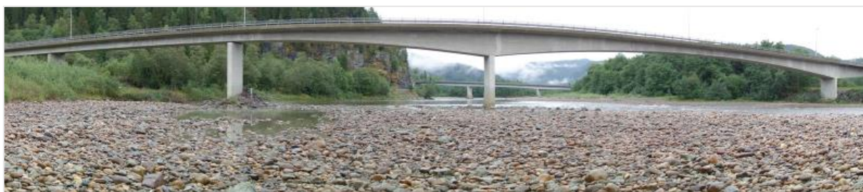
Figur 3-3 Eksisterende bru over Gaula. I bakgrunnen sees fv. 632 Folstad bru.
