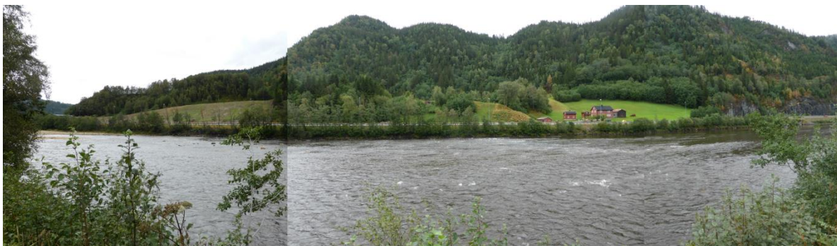
Figur 12: Bilde av Rostad og planlagt påhuggsområde og utgraving til fjell. Bebyggelsen til høyre i bildet må erverves
