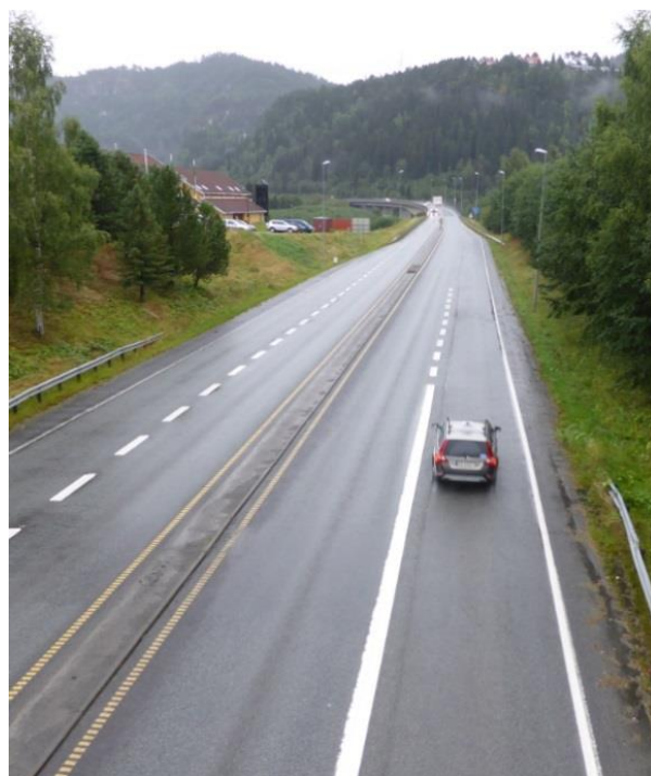
Figur 19: På E6 gjennom Prestteigenkrysset og nordover.
