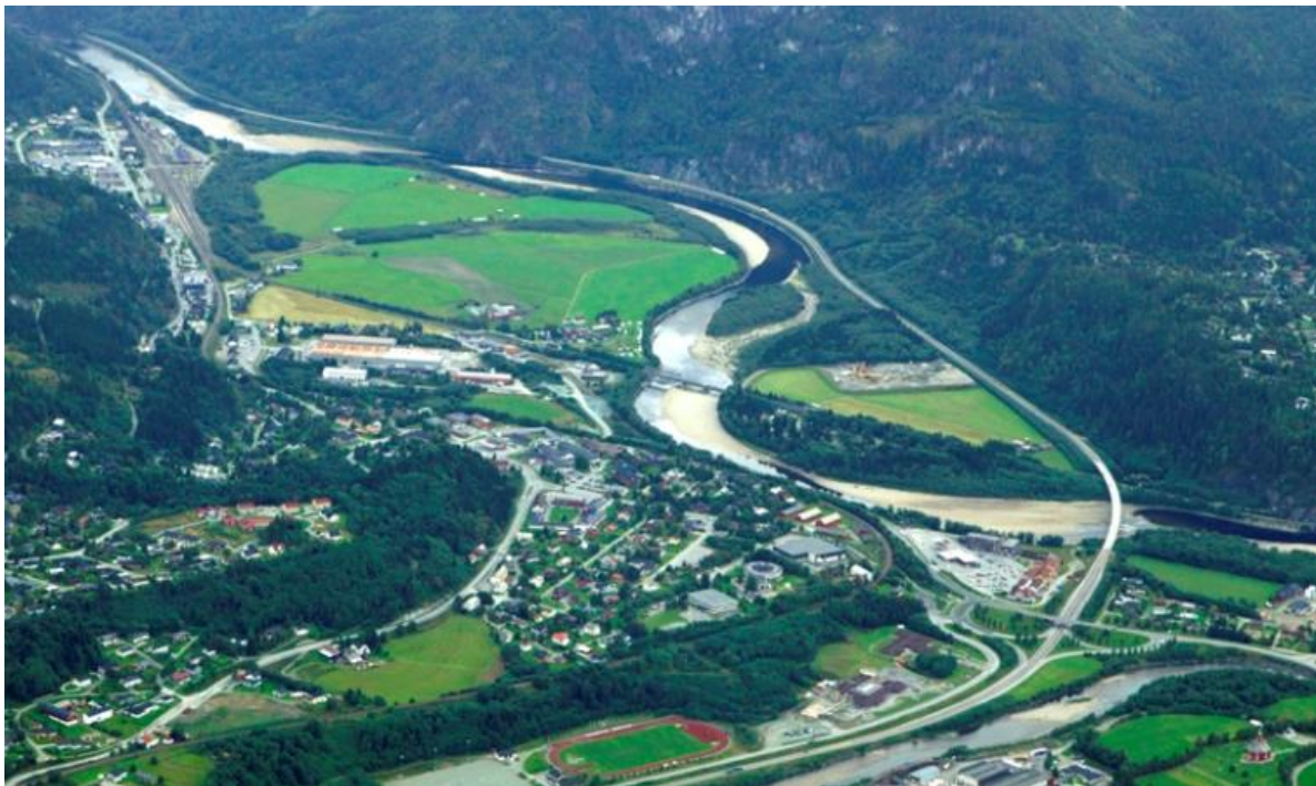
Figur 16: Oversiktsbilde fra Støren sentrum med Prestteigenkrysset nede til høyre. Eksisterende E6 nordover dalen øst for Gaula.
