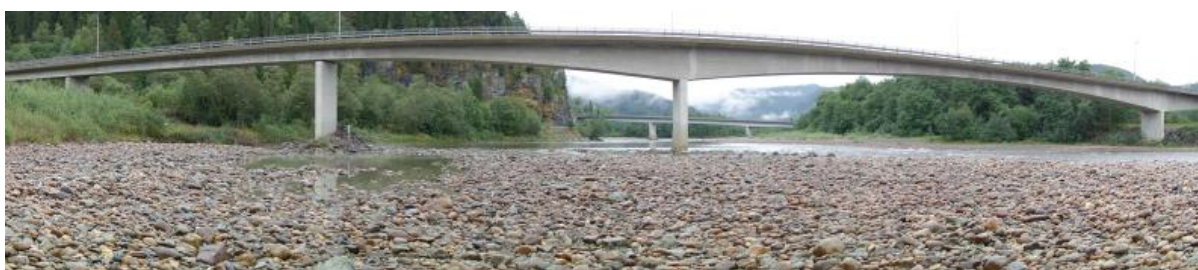
Figur 4: Eksisterende bru over Gaula. I bakgrunnen sees fv. 632 Folstad bru.
