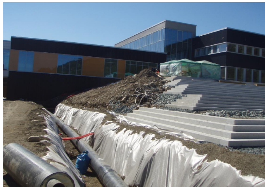
Etablering av vannbåren varme ved Gauldal videregående skole.
