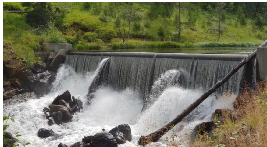
Råfossen kraftstasjon. Foto: Midt Energi AS.
