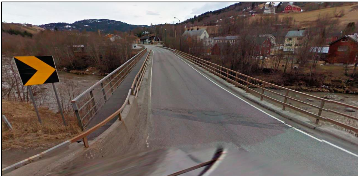
Figur 14: Foto som viser eksisterende kjørebru over Sokna. Kilde: google.
