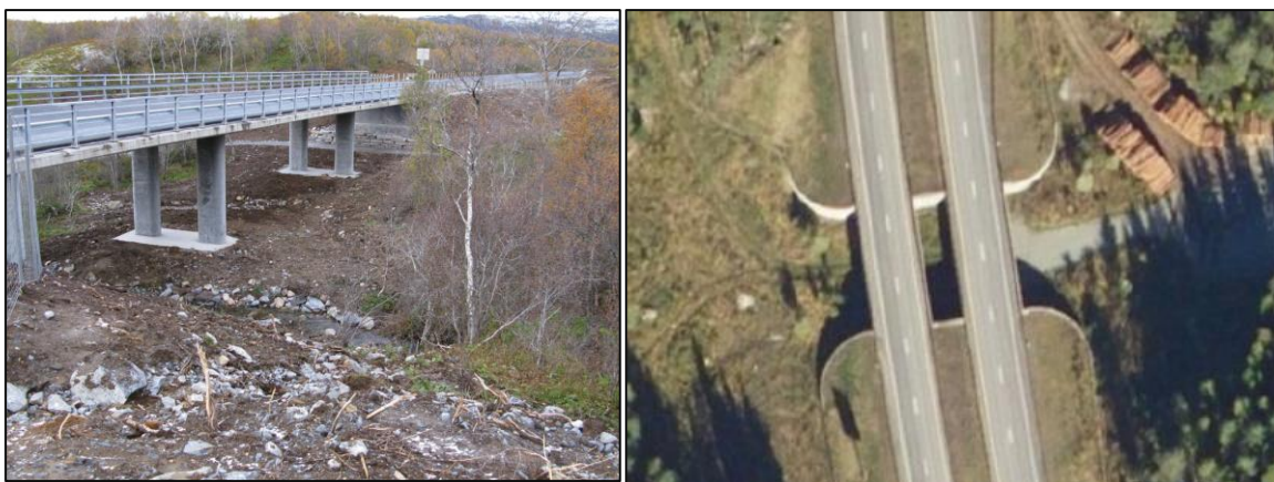
Figur 11. Eksempler på bruer som er tilpasset viltkryssing. Bru til venstre er det også tilrettelagt for lokalvei og elv.
