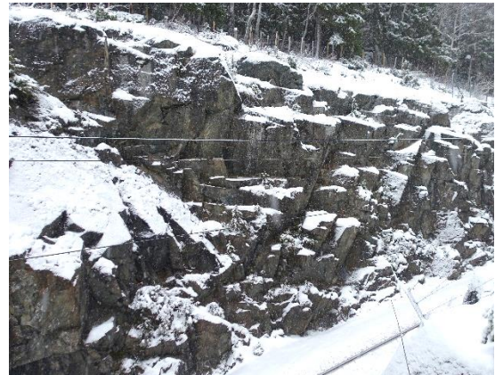
Figur 13: Skjæring i berg langs jernbanelinja, ca. 40 meter øst for profil 900
