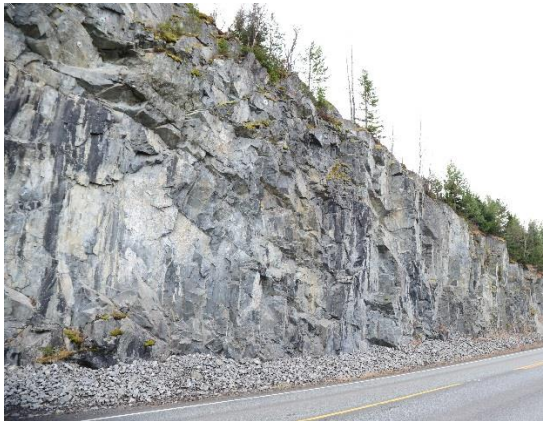
Figur 12: Skjæring i berg langs eksisterende E6, ca. ved profil 350.
