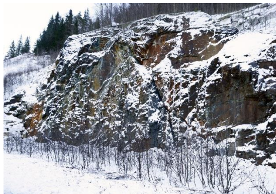
Figur 49: Skjæring i berg langs eksisterende E6, ca. profil 1550. Grovblokkig bergmasse, jevn skjæringsvegg med synlige borpiper
