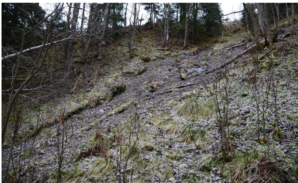
Figur 50: Eldre løsmasseskred i sideterrenget, ca. 90-100 meter sør for profil 1550.
