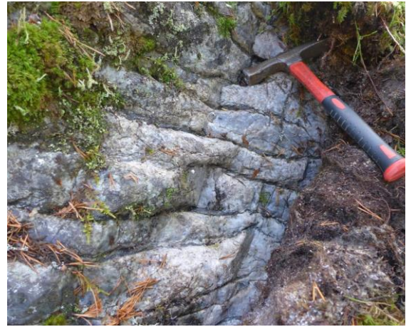
Figur 21: Bergblotning ca. profil 2800
