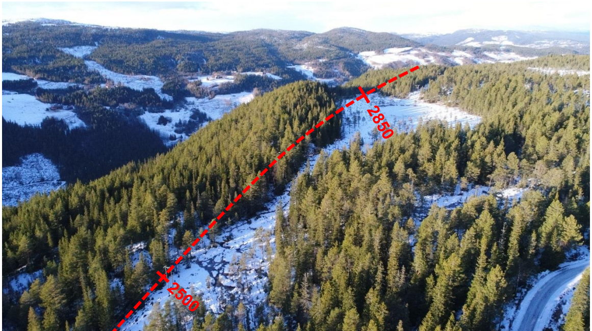
Figur 19: Oversiktsbilde sett mot nord. Ca. plassering av trasé med profilnummer er vist ved rødstiplet linje.
